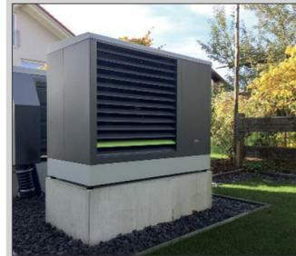
Plaziert wurde die x-change dynamic Luft/Wasser-Wärmepumpe zusammen mit einem baugleichen Gerät, welches die zweite Hälfte des Doppelhauses beheizt, auf einem Betonfundament im Garten. Die x-center x40-Regelung der Wärmepumpe ist im Keller bei den Speichern angebracht.
