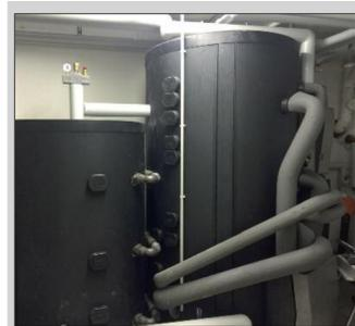
Gespeichert wird die thermische Energie der Wärmepumpe und des Holzofens im x-buffer Schichtenpufferspeicher (1250l) und einem Beistellspeicher (600l). In Kombination mit dem Akku-Stromspeicher steht somit nahezu ganzjährig Wärme zur Verfügung, ohne dass dafür Strom aus dem öffentlichen Netz bezogen werden muss.
