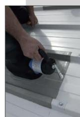
der Verarbeiter die Manschette an die Profilierung des Sandwich-Elements an. Da die Manschette selbstklebend ist, ist eine zusätzliche mechanische Verschraubung auf der Metalloberfläche nicht erforderlich. Die Manschette besteht aus PIB mit selbstverschweißenden Eigenschaften. So kann sie gegebenenfalls mit Wakaflex-Anschlussband auch verlängert werden.
