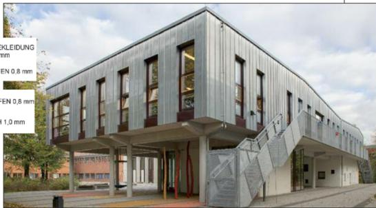
mit ein. Ein traditionelles Fassadenmaterial mit natürlicher Oberfläche, wartungsfrei und witterungsbeständig durch selbständige Schutzschichtbildung (Patina), optische Zurückhaltung durch die matt-mittelgraue Oberfläche und dadurch zudem eine dezente Hervorhebung der architektonischen Gestaltung des Baukörpers. Unterschiedliche Materialzu-
