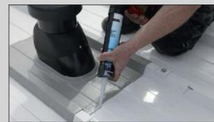
ze reduziert. Anschließend kann der Dachdecker die Stoßkante mit dem Dicht- und Montagekleber dauerhaft versiegeln.
