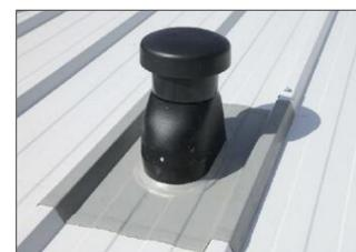
Dach statisch zu bemessen sind. Dabei sind Öffnungen bis zu einer Größe von 125 mm x 125 mm im Bereich von Feldmomenten einer Trapez- oder Wellprofiltafel ohne weiteren Nachweis zulässig, wenn sie nicht mehr als 10 Prozent der Stützweite vom Endauflager oder den Momentenullpunkten entfernt sind. Öffnungen bis zu einer Größe von 300 mm x 300 mm dürfen unter bestimmten Bedingungen ohne statisch wirksame Ausweichungen
