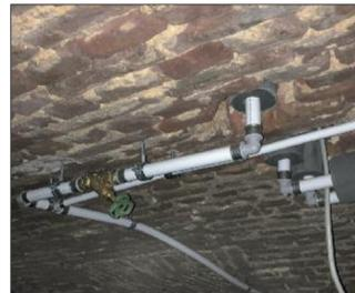
Für die hygienische Trinkwasserverteilung im ganzen Haus installierte der Fachbetrieb Samid Huskic ein Rohrleitungssystem mit Komponenten des Roth Rohr-Installationssystems.
