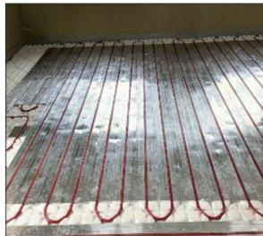
Im Obergeschoss des denkmalgeschützten Gebäudes kam Roth KlimaComfort TBS zum Einsatz. Das Trockenbausystem für die Fußbodenheizung eignete sich aufgrund des geringen Flächengewichts sowie der niedrigen Aufbauhöhe.
