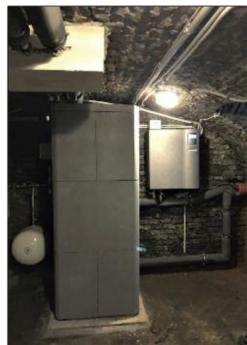
Der Kunststoff-Wärmespeicher Roth Thermotank Quadroline wiegt nur 50 Kilogramm und ließ sich daher leicht transportieren und installieren. Bild unten: Verlegung des Fußbodenheizungssystems.
