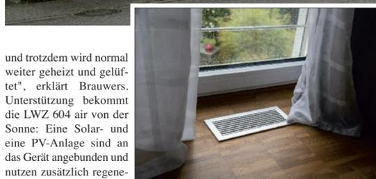
Im Obergeschoss befinden sich die Luftauslässe im Boden.
