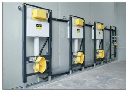
Die hohe Flexibilität von Prevista zahlte sich auch bei Leica Microsystems aus, hier in Form einer nur teilweise aufgesetzten Vorwandkonstruktion in U-Profilen für einen Waschtisch und drei WCs.
