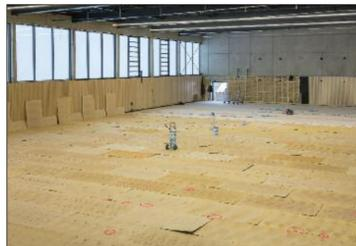
Im vorderen Bereich sind die PUR-Hartschaumplatten zu sehen, die als Dämpfer im Bodenaufbau wirken. Diese werden mit Sperrholzplatten abgedeckt, die im hinteren Bereich des Bildes bereits verlegt sind.
