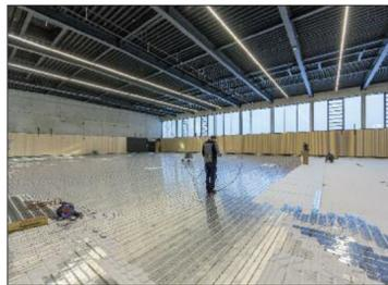
Das Trockenbausystem TECEfloor ist hier größtenteils bereits verlegt. Im Vordergrund ist das Umgehen der Einbauhülsen für die Turngeräte zu sehen.
