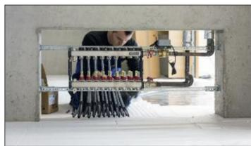
Die 36 Heizkreise für den Sporthallenboden werden über vier TECEfloor Edelstahlverteiler versorgt. In jedem Geräteraum sind je zwei Stück installiert.
