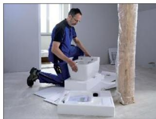
Der Styroporträger im Bild oben dient als kräfteschonender Abstandshalter bei der Montage von TECEone. Mit dem cleveren Schnell-Montagesystem im Bild rechts geht die Wandbefestigung der TECEone-Keramik einfach und zeitsparend von der Hand.
