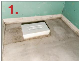
Die Easy Connect Installationsbox von Bette nachdem der Estrich eingebracht wurde. Der Deckel schützt den Ablauf im Inneren vor Schmutz und Beschädigungen.
