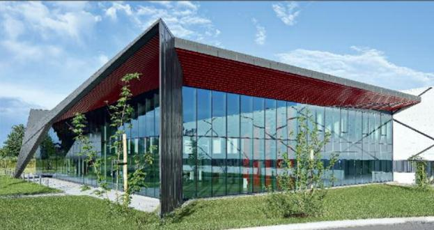
Auch die rote Dachuntersicht war eine Herausforderung: An der Unterseite zunächst ein ebenes Basisblech montiert, auf das anschließend einzeln gefertigte und lackierte Hutprofile gesetzt wurden. Dadurch konnte die Bekleidung der wiederum sehr verschieden geformten und geneigten Untersichtflächen genau an die Decke im Innern des Foyers angepasst werden, sodass die Sicken ein optisch perfekt durchlaufendes Linienbild bilden.
