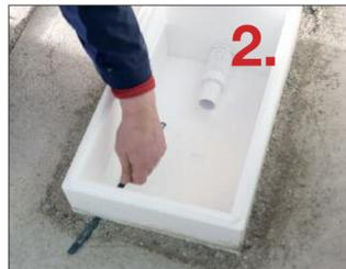
Die Installationsbox wird auf die benötigte Höhe zugeschnitten. Die Einbauhöhe kann zwischen 105 und 205 mm flexibel gewählt werden, eine Unterfütterung der Box ist nicht nötig.
