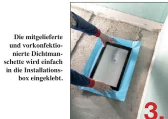
Die mitgelieferte und vorkonfektionierte Dichtmanschette wird einfach in die Installationsbox eingeklebt.
