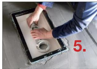
Bevor die Duschwanne aufgesetzt wird, muss noch der Ablauf hergestellt werden. Hier setzt man auf die selbstreinigende Ablaufgarnitur BetteSolid.
