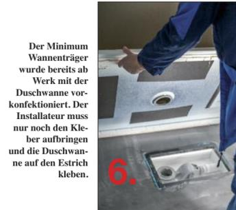
Der Minimum Wannenträger wurde bereits ab Werk mit der Duschwanne vorkonfektioniert. Der Installateur muss nur noch den Kleber aufbringen und die Duschwanne auf den Estrich kleben.
