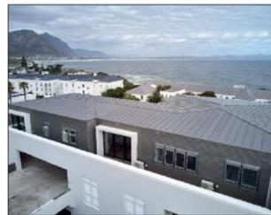
herrschenden Witterungseinflüsse. Das Dach im Doppelstehfalzsystem aus werkseitig vorbewittertem NedZink NOVA Bandmaterial 0,80 x 600 mm bietet eine klare Linienführung und unterstreicht den hochwertigen Charakter des Penthouse-Designs. Die verwinkelten Walmdachflächen sind durch Gratleisten voneinander getrennt und segmentiert - eine technische und optisch einwandfreie Lösung. Das kühne Design ist völlig einzigartig für die Gegend und somit ein echter Blickfang.
