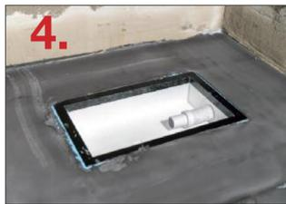
Nach Einbringen der Dichtschlämme durch den Fliesenleger ist Easy Connect normgerecht nach DIN 18534 in die Verbundabdichtung integriert.
