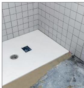
**Wichtig im Hotel:** Neben der Zeitersparnis bietet die praxisnahe Lösung von Bette auch eine hervorragende Geräuschdämmung. Bei einer Montage auf Estrich inklusive Dämmung wird die Kombination aus superflacher Dusche und Minimum-Wannenträger mit einem Schallpegel von nur 17 dB(A) auch den erhöhten Anforderungen der Schallschutzstufe 3 der VDI 4100 mehr als gerecht.
