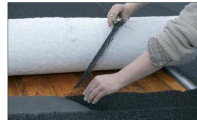
Der mehrlagige Aufbau der Permo sec SK (Vlies-Dichthaut-Gitter-Vlies-Monoflammentgelege) übernimmt nicht nur die Funktion der Regensicherheit, sondern im Konstruktionszusammenhang auch weitere Aufgaben. An heißen Tagen kann die Unterkonstruktion befangen werden, eine Verschmutzung der Eindeckung beim Begehen, wie von bituminösen Bahnen bekannt, ist somit ausgeschlossen.
